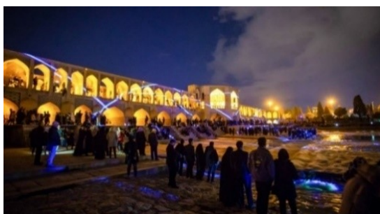
تصویر شماره ۵: پل خواجو شهر اصفهان (Imna, 2019)
